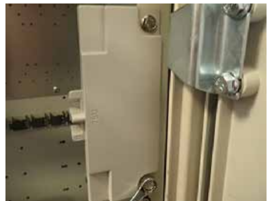
2 Montage du kit bobine (d + e) Mounting spool kit (d + e)
