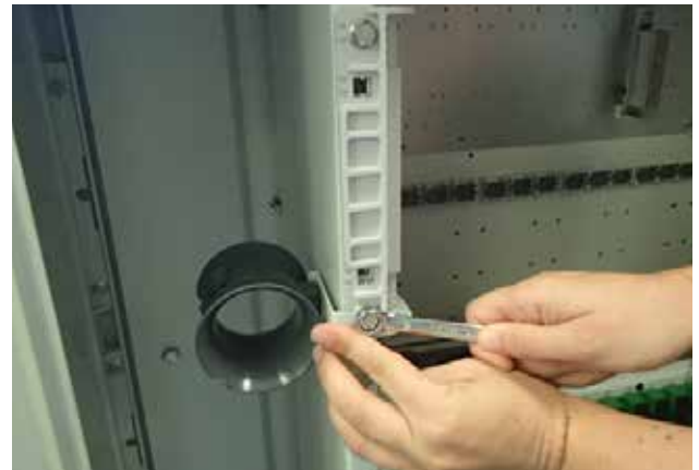
2 Montage du kit bobine (d + e) Mounting spool kit (d + e)
