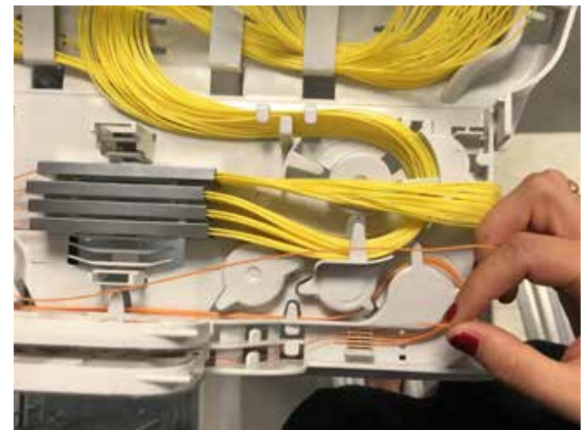
4 Délover et couper l'épissure du tronc du coupleur Uncoil and cut the splice of the splitter input
